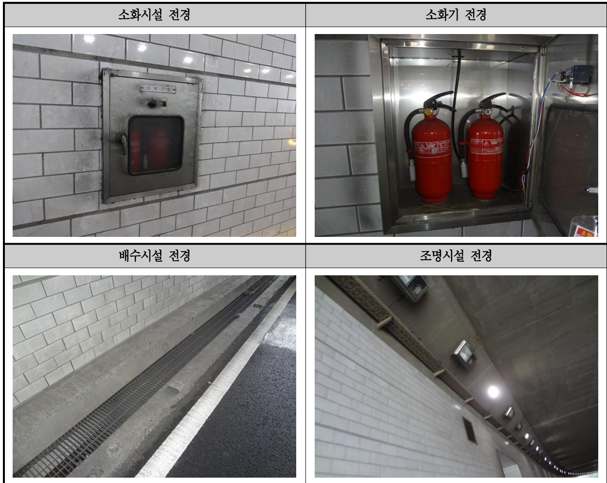
【그림 3.2.9】 부속시설 전경
